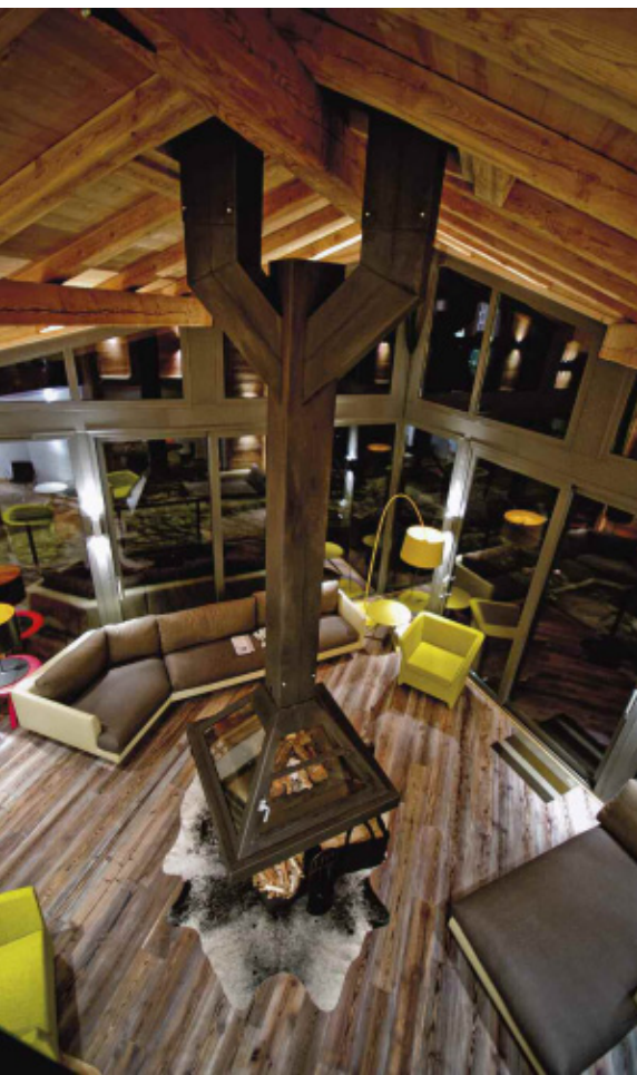
La proue du salon est dirigée vers le sommet du Mont-Blanc. La cheminée suspendue de plus de 800 kg est astucieusement portée par une panne faîtière, avec des renforts discrets.
